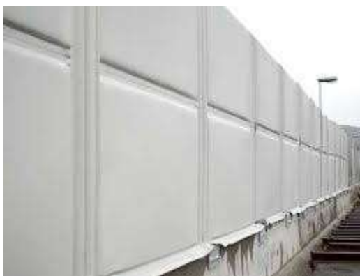
Figura 60 - Barriera cieca mobile
